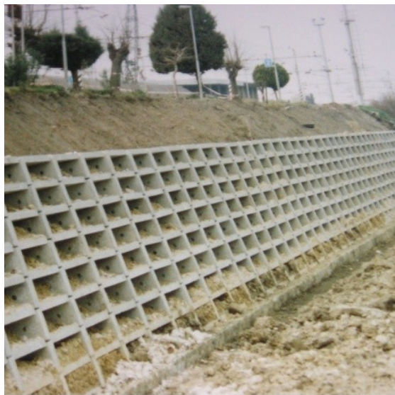
Illustrazione 14: Linea ferroviaria in rilevato
